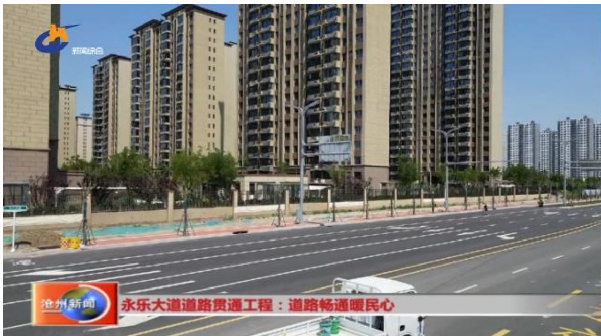
《沧州新闻》栏目 2024 年 6 月 1 日播发《永乐大道道路贯通工程：道路畅通暖民心时间》
