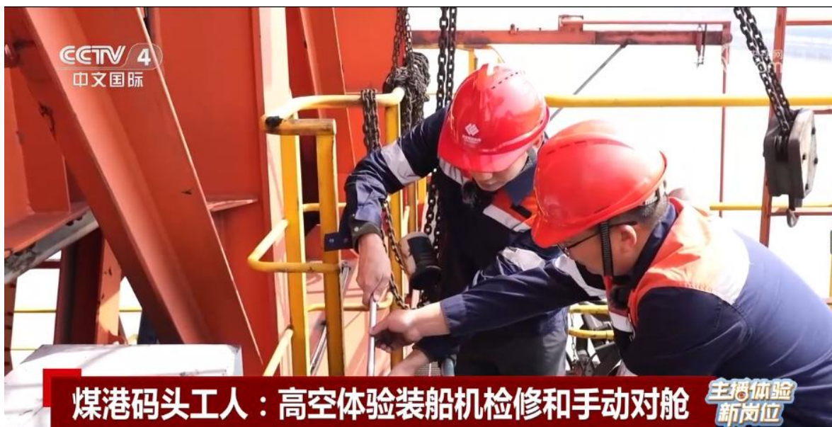
中央电视台《中国新闻》栏目 2024 年 5 月 4 日播发《主播体验新岗位 煤港码头工人：高空体验装船机检修和手动对舱》
