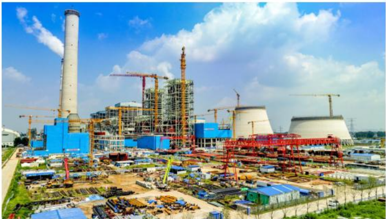
图为施工现场。白永民摄
