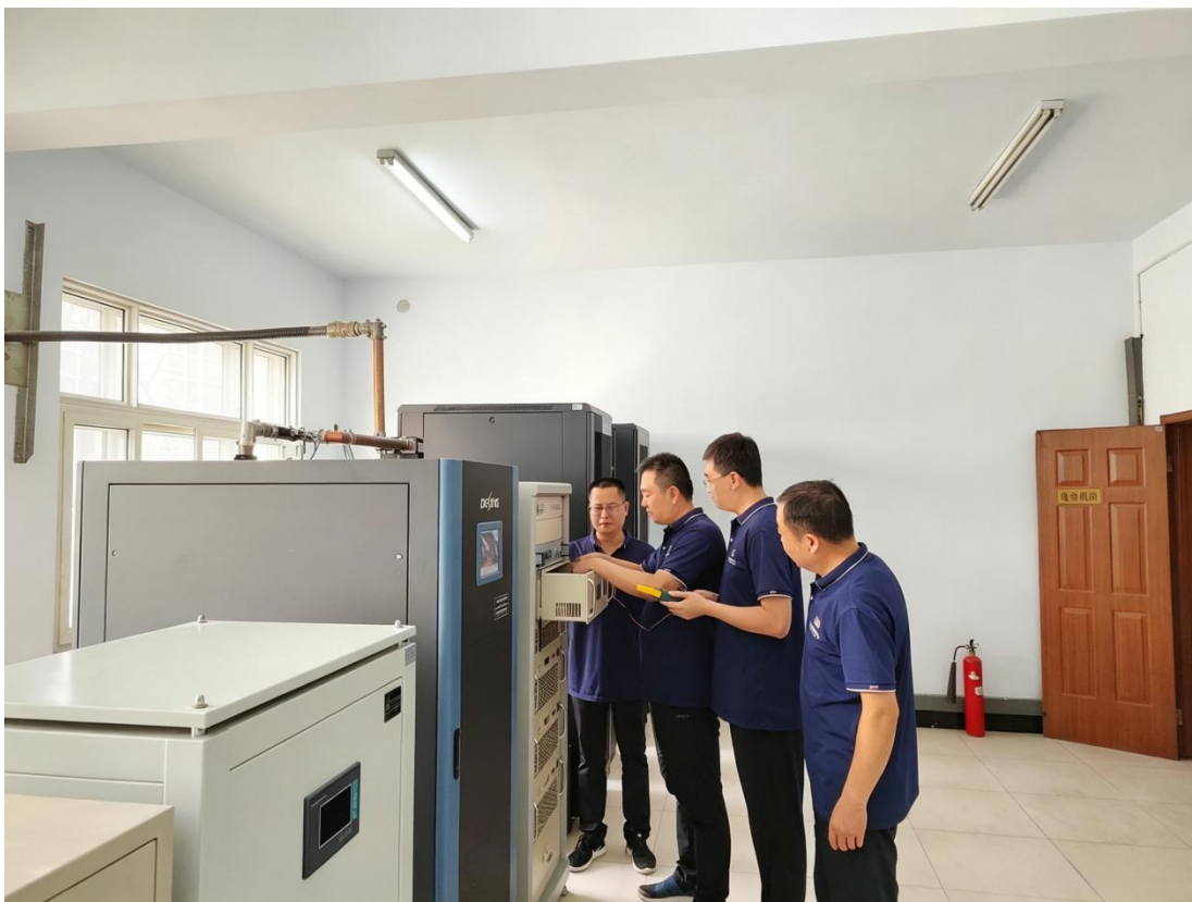
技术人员对机房设备进行检修
