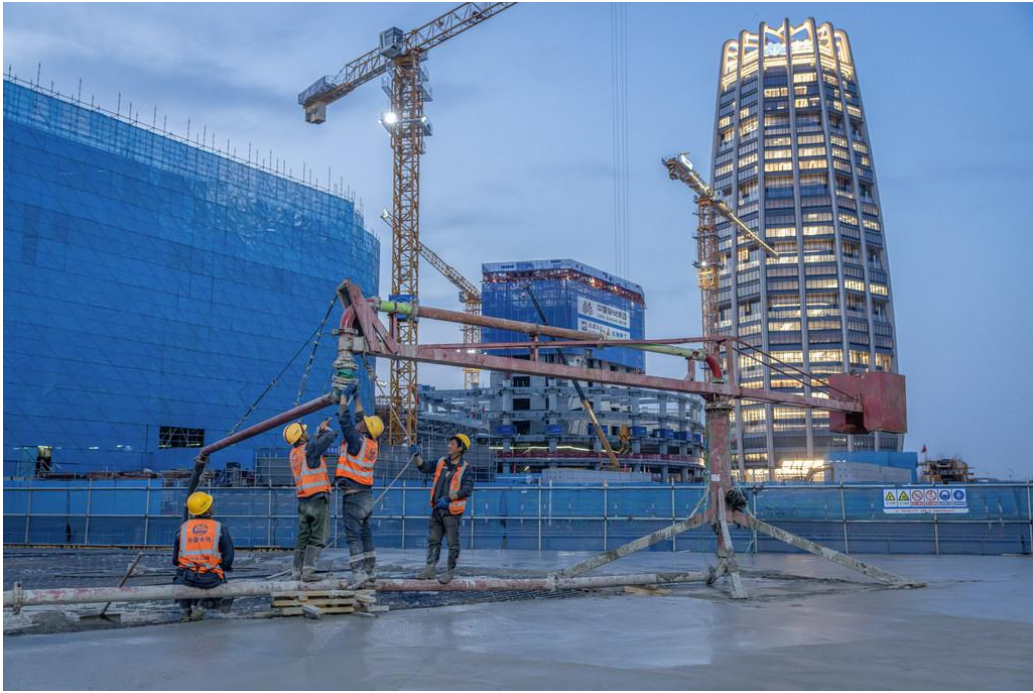
雄安新区启动区内重点项目建设正在稳步推进。
